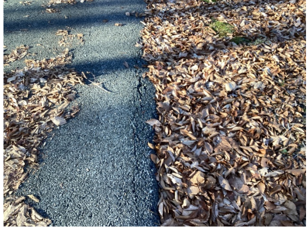
Edge deterioration
