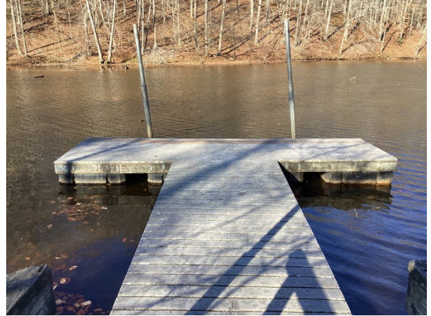
Pile displacement
